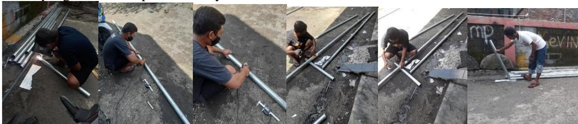
Gambar 5. Pengukuran dan pembuatan penerangan lampu jalan
